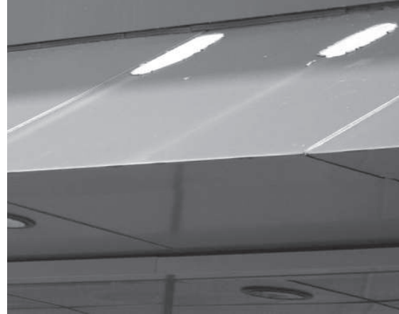
Aluminiozko bandejak korrosio-hasierarekin.
