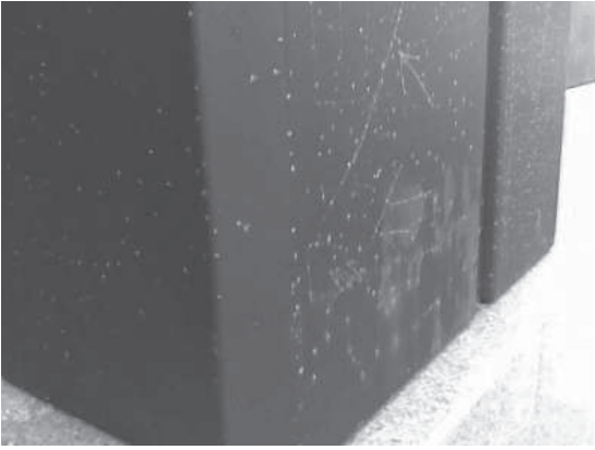
Lakatutako altzairuzko bandeja korrosio-hasierarekin.
